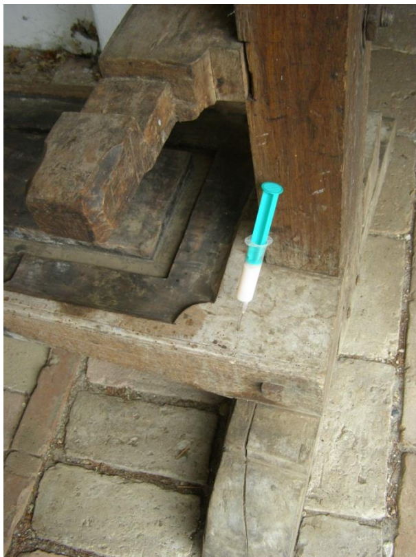
Vegyszer injektálása a szű járatokba.
