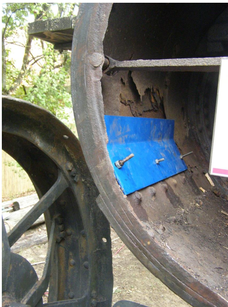
A deformálódott oldallemmez megerősítése.
