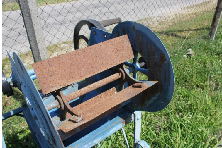
A korrodált szelelő.
