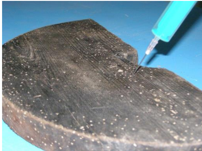
Faanyagvédő és rovarölőszer injektálása a szú járatokba
