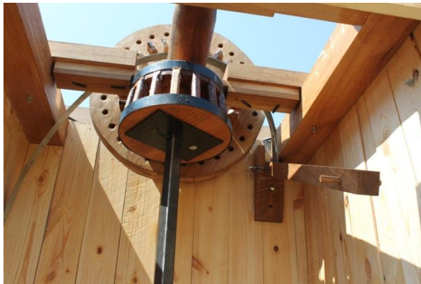
Beszerelt hajtószerkezet.
